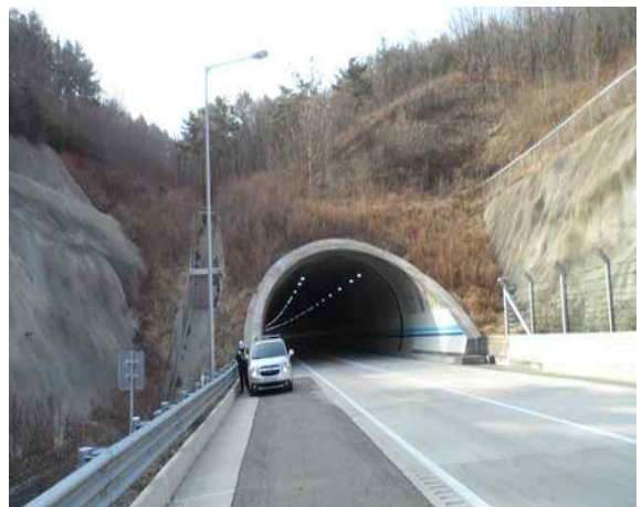
4공구 산법터널(상주방향) (4공구) 종점부
