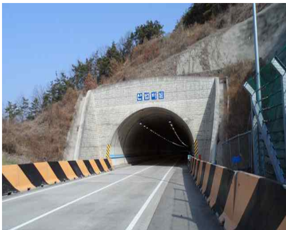
4공구 산법터널(상주방향) (4공구) 시점부
