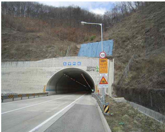
5공구 효령터널(상주방향) (5공구) 시점부
