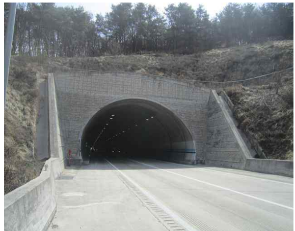
5공구 효령터널(상주방향) (5공구) 종점부
