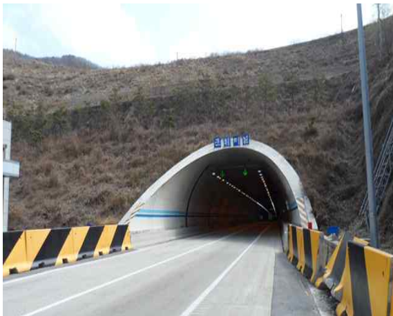
3공구 군위터널(영천방향) (3공구) 시점부
