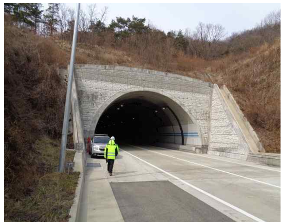
4공구 평호터널(영천방향) (4공구) 종점부
