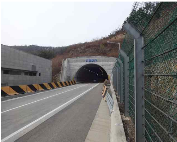
4공구 평호터널(상주방향) (4공구) 시점부
