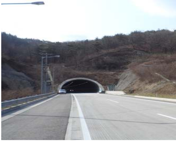
4공구 산법터널(영천방향) (4공구) 시점부
