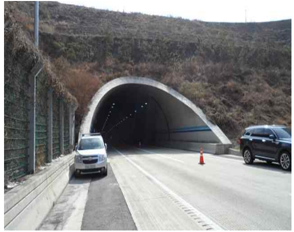
3공구 군위터널(상주방향) (3공구) 종점부
