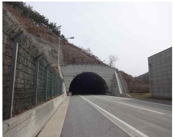
4공구 평호터널(상주방향) (4공구) 종점부
