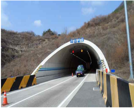
3공구 군위터널(상주방향) (3공구) 시점부
