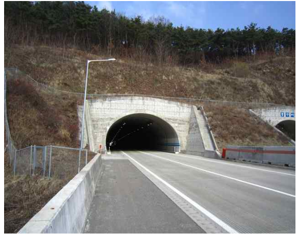
5공구 중구터널(영천) (5공구) 종점부
