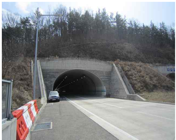
5공구 중구터널(상주) (5공구) 종점부
