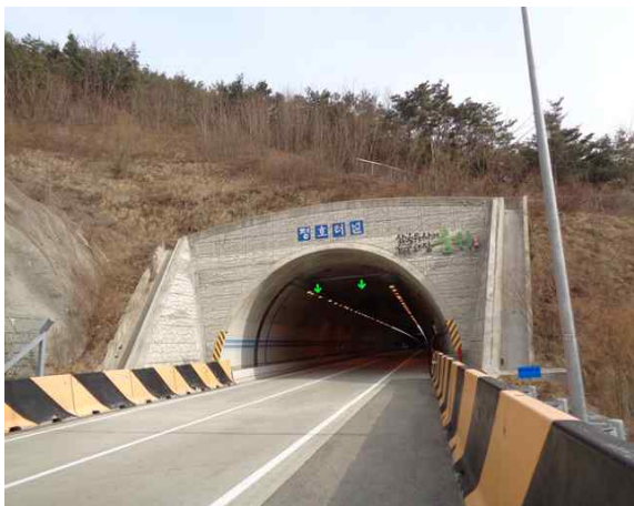
4공구 평호터널(영천방향) (4공구) 시점부
