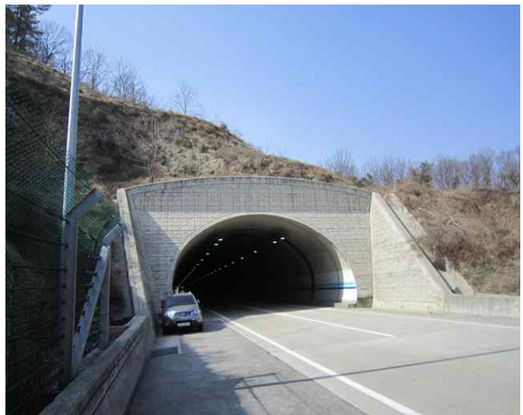
5공구 불로터널(영천) (5공구) 종점부
