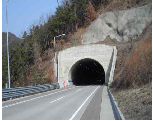
4공구 산법터널(영천방향) (4공구) 종점부
