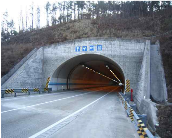
5공구 중구터널(영천) (5공구) 시점부
