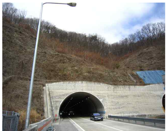
5공구 효령터널(영천방향) (5공구) 종점부
