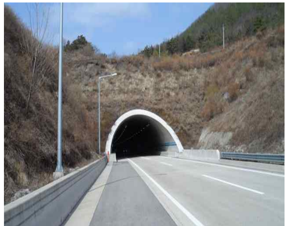
3공구 군위터널(영천방향) (3공구) 종점부
