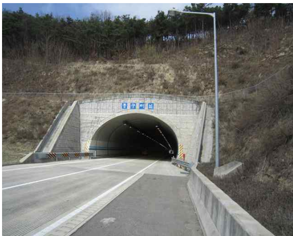
5공구 중구터널(상주) (5공구) 시점부
