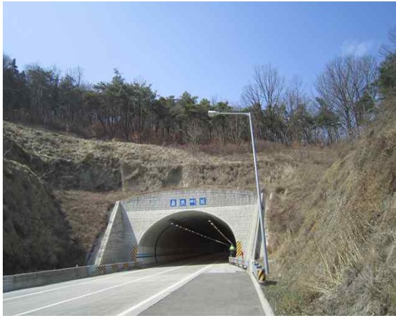
5공구 불로터널(상주) (5공구) 시점부
