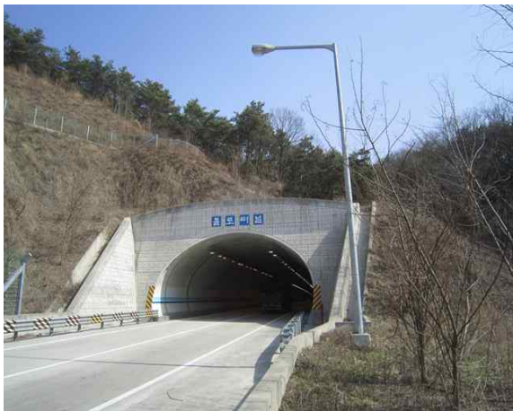
5공구 불로터널(영천) (5공구) 시점부
