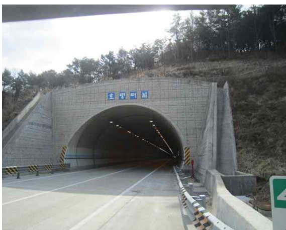
5공구 효령터널(영천방향) (5공구) 시점부
