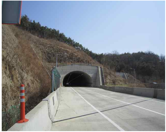
5공구 불로터널(상주) (5공구) 종점부
